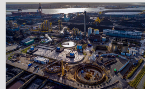
Waterzuiveringsinstallatie verbouwen Het meeste gebeurt ondergronds, maar ook aan de nieuwe CombiBio waterzuiveringsinstallatie wordt nog steeds hard gewerkt!
