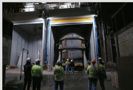
Droogstandinstallatie testen Op dit moment testen we de nieuwe droogstandinstallatie van de Staalafabriek. Dat
